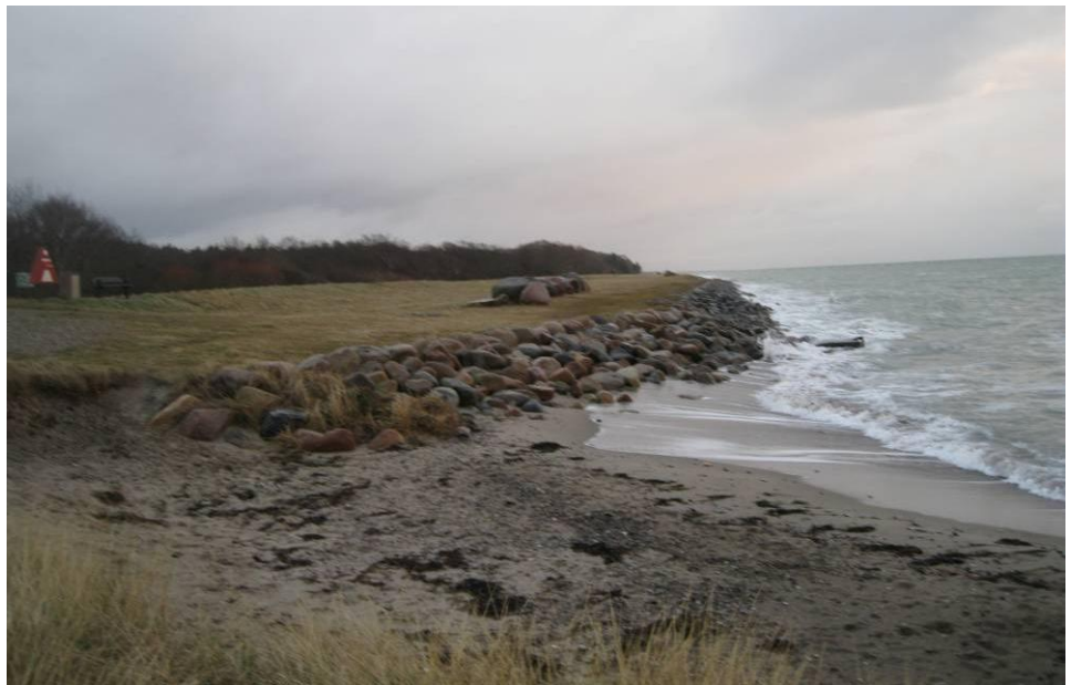
Figur 13: Næsby Strand mod Sydøst. Stranden er genstand for læsideerosion skabt af de kystparallelle høfder. Skoven, som når helt ud til diget ses i baggrunden.
