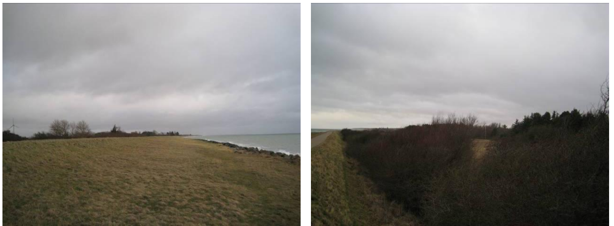
Figur 27: Venstre: Dige ved Dannemare Strand. Højre: Den ny udstykning er trukket 100 m tilbage fra diget.
