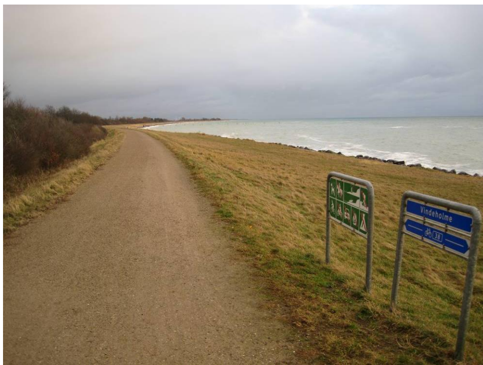
Figur 16: Vindeholme Strand. Ingen naturlig strand: Diget er beskyttet af stenkastning mod bølgenes nedbrydning.
